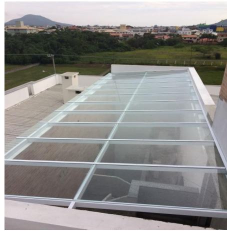
VISTO SUPERIOR TELHADO DE VIDRO
