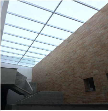
VISTA ESCADA E TELHADO DE VIDRO
